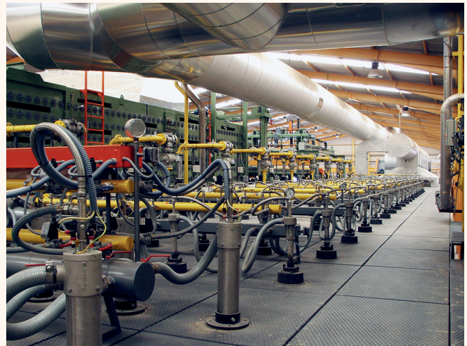
Figura 1. Horno con recuperadores de calor hacia secadero, para la optimización del consumo energético.
