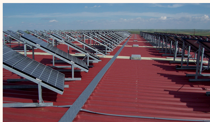
Figura 5. Instalación de paneles solares fotovoltaicos en cubierta.
