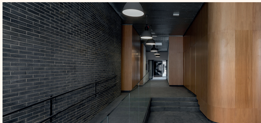
Figura 8. Paredes cerámicas que garantizan la seguridad frente a robos y la resistencia a los posibles impactos. Rehabilitación de edificios para 105 viviendas y locales anejos, Madrid. Arquitecto: Antonio Ruiz Barbarín. Fotografía: Luis Asín
