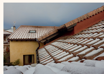
Figura 12. Cubierta con teja cerámica cuya robustez y estanqueidad garantizan el confort y protección en condiciones climáticas adversas
