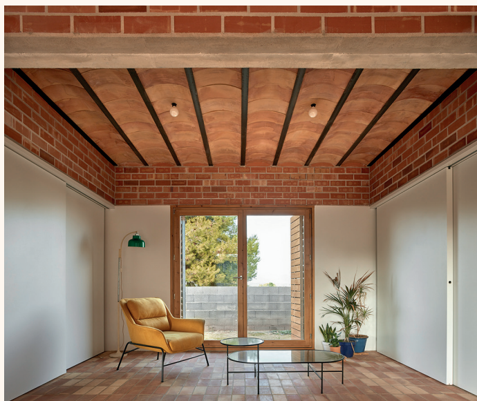
Figura 5. Vivienda unifamiliar "Casa en Bétera" con forjado cerámico en Valencia. Arquitectos Hugo Mompó, Juan Grau, Ramon Campos (Quadrat Estudio). Fotografía: Mariela Apollonio
