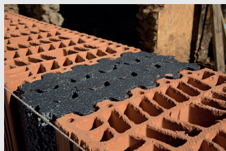
Figura 9: Pieza especial de control del puente térmico en el ajuste del bloque Termoarcilla.
