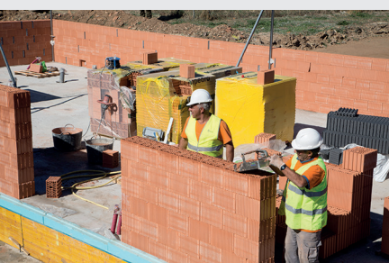
Figura 4: Puesta en obra Termoarcilla rectificada. reducción puente térmico y obra en seco.
