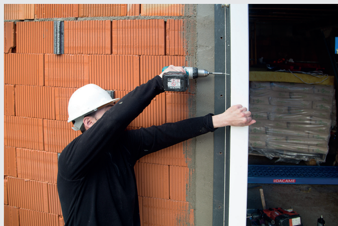
Figura 10: Fijación ventana a Termoarcilla.
