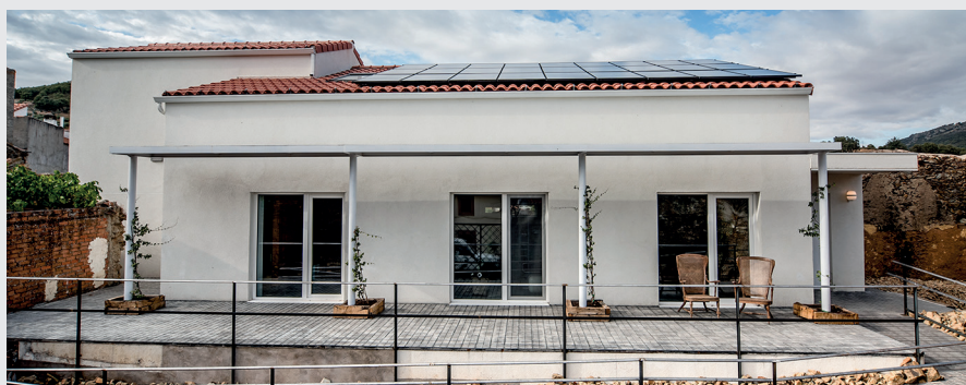
Figura 1: Vista general. Orientación sur exacta, control solar maestro fijo, balconeras con ganancia térmica controlada, cubierta y campo solar.
