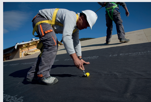
Figura 15: Instalación de la lámina de cubierta y uso de herramienta adecuada.
