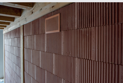
Figura 17: Detalle muro Termoarcilla como interiorismo, mismo acabado que en uso estructural.
