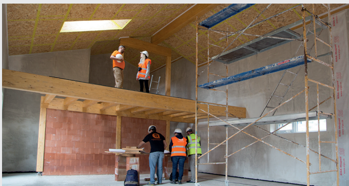
Figura 12: Enlucido interior como capa hermética sobre Termoarcilla.
