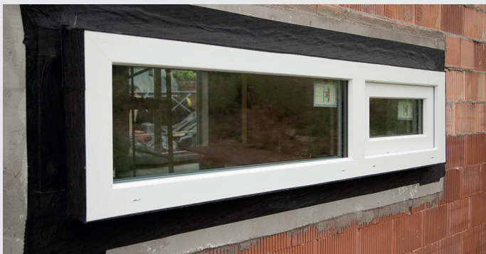
Figura 11: Ventana norte acabada. Completo embebido de envoltente opaca -Termoarcilla- y envoltente transparente -ventana-.
