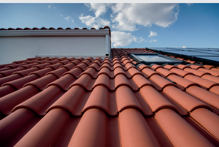
Figura 16: Dos cubiertas, ventilada y maciza y detalle de campo solar y ventana en cubierta para control solar específico.
