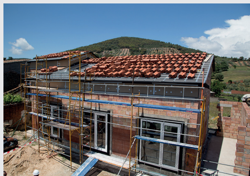
Figura 14: Vista general dos cubiertas, dos Termoarcillas.
