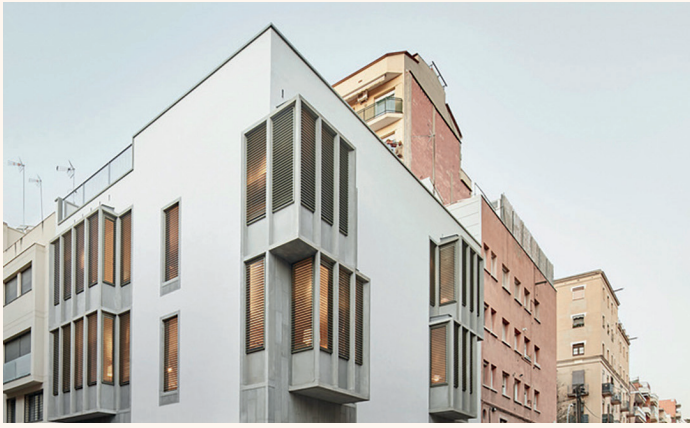
Figura 6. Bloque de viviendas en Barcelona, con cerramiento de bloque cerámico aligerado revestido con un sistema SATE. Arq. Raimon Farré Moretó. Foto: José Hevia
