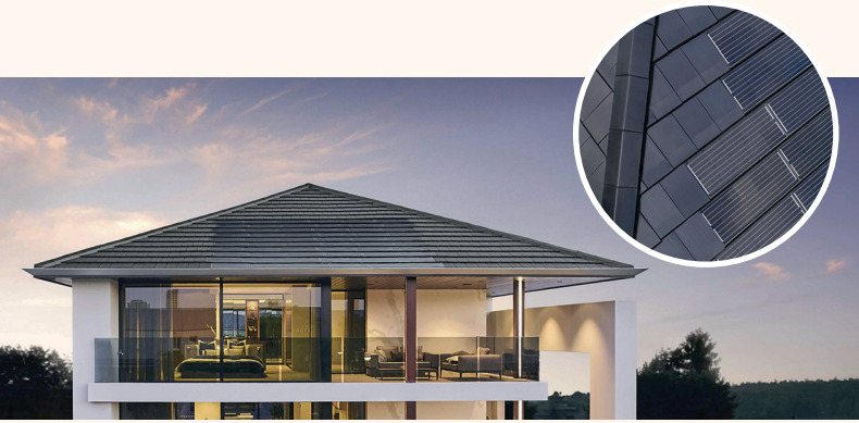
Figura 18. Cubierta con tejas fotovoltaicas
