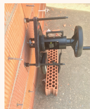
Figura 5. Ensayos de anclajes para fachada ventilada
