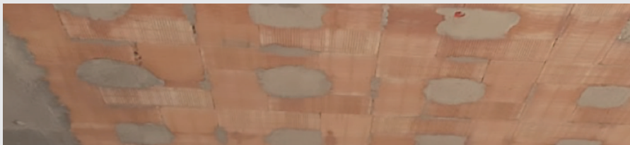
Fig. 15. Parte inferior de forjado. Datos generados en cruces de nervio, válidos como apoyos durante la fase de desencofrado.
