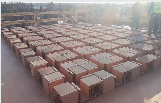
Fig. 8. Obra en Benguerir. Colocación casetón cerámico.
