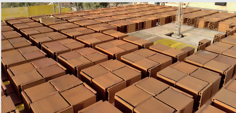
Fig. 9. Obra en Villena. Colocación casetón cerámico CRECE®.
